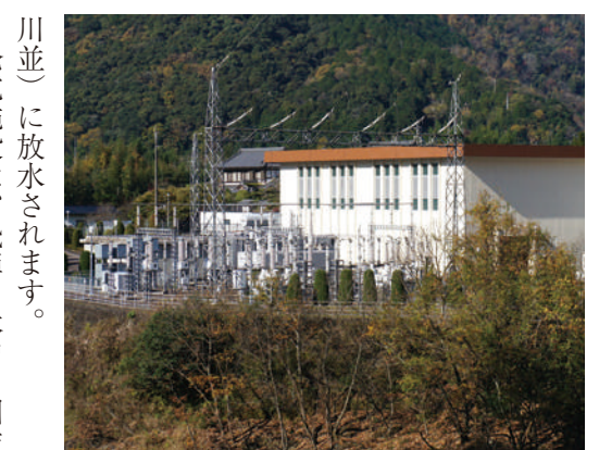
新上麻生発電所
