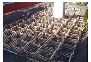
橋脚の根固め工として採用された木工沈床(井納建設株式会社ホームページより)
