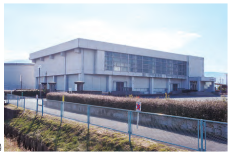
海津北部浄水場
