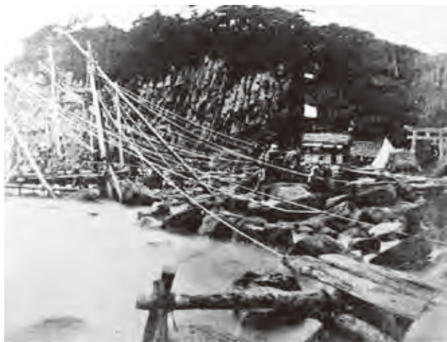
雄島からの採石〔第21回特別展 明治三大築港展〕(みくに龍翔館、平成16年)より
