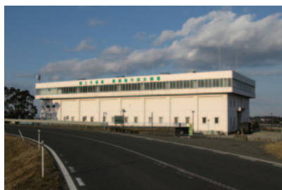
高須輪中排水機場
