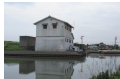
森下排水機場
