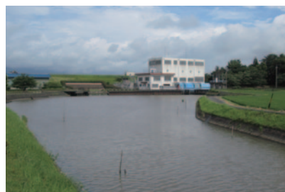
脇野排水機場
