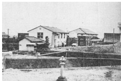
昔の中江排水機場と記られている燈明
