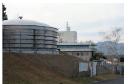
中津川浄水場
