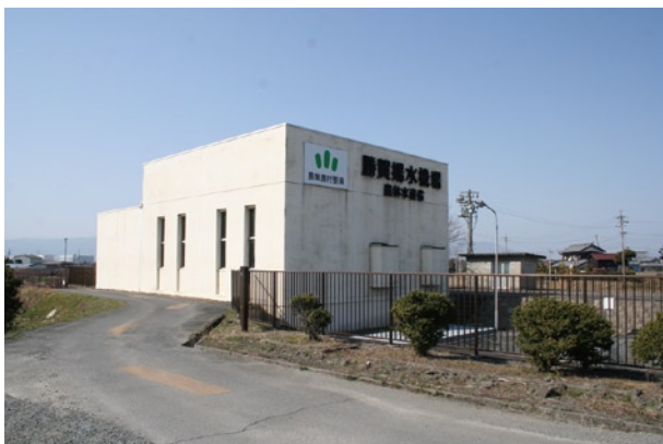
海津市平田町勝賀の勝賀揚水機場
