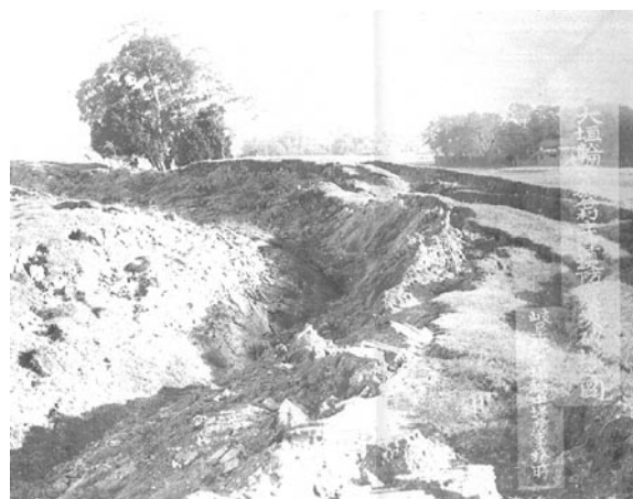
揖斐川堤防の被害
