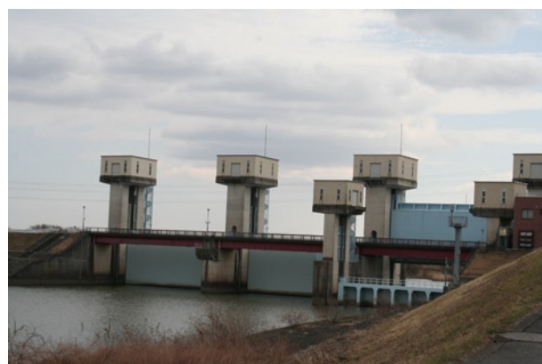
南濃町羽沢の津屋川水門
