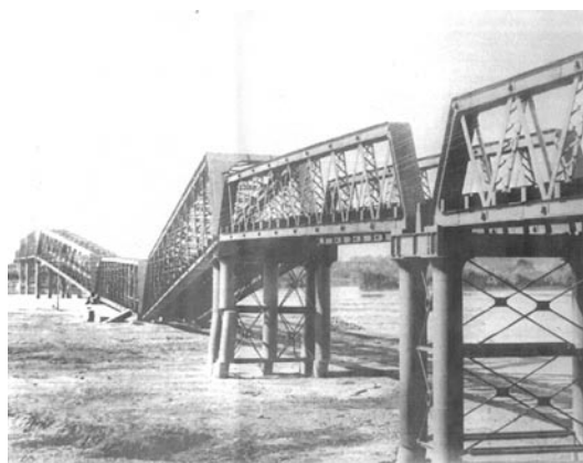
長良川鉄橋の崩落
