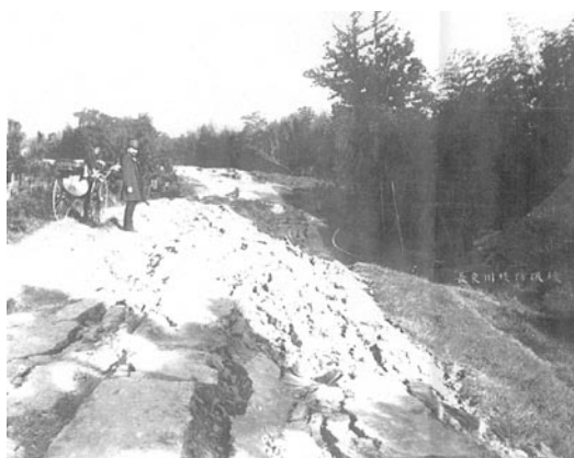
長良川堤防の被害
