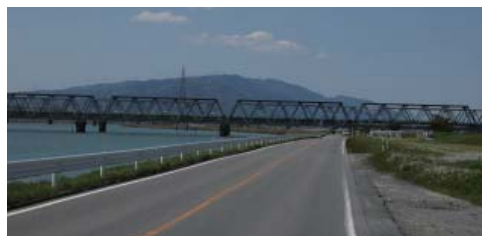
JR橋梁下流の背割堤 このため、東名阪橋梁からJR鉄道橋までの区間で背割堤の法線に合わせて約七〇〇mの「縮切堤防」を明治三三(一九〇〇)年から三四年にかけて築造し、旧揖斐川を締め切りました。
