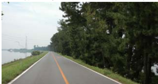
油島地先の縮切堤部分 右の松林は江戸時代の縮切堤部分
