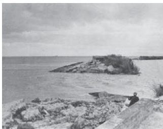
長島海岸堤防の破壊状況
