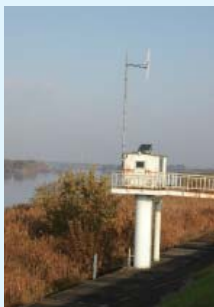
揖斐川今尾水位観測所
