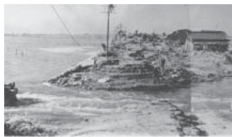
河川堤防(木曽岬町雁ヶ地)の破壊状況
