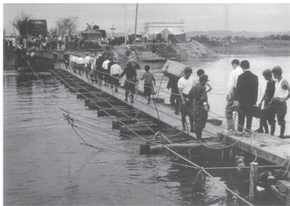
国道1号長栄橋が流失したため、自衛隊によって架橋されたベリール橋
