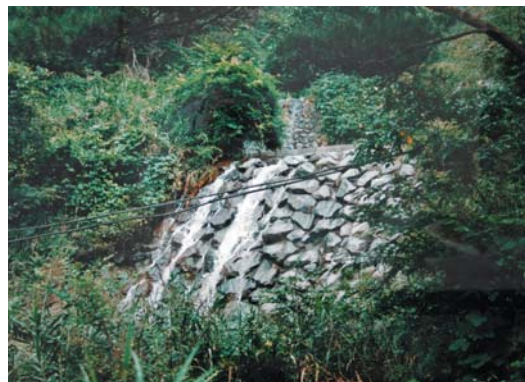
小川谷の巨石積堰堤
