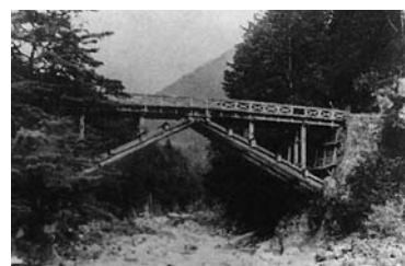
旧国道に架かる大正期の滑川橋
