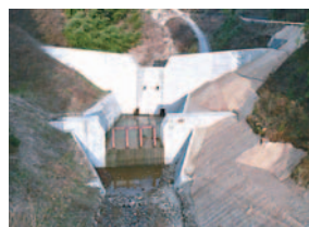
本沢川第一砂防堰堤
