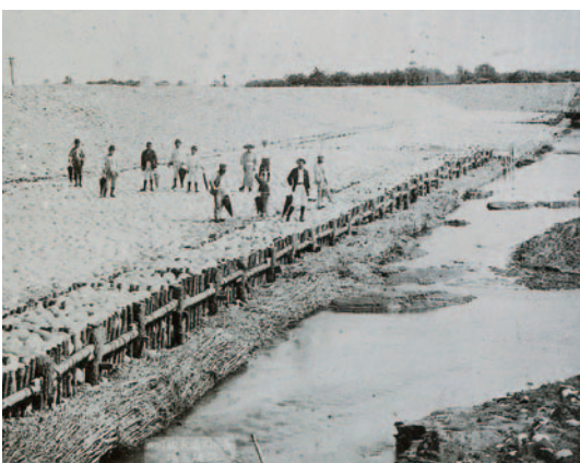
大樽川洗堰(明治年間使用)
