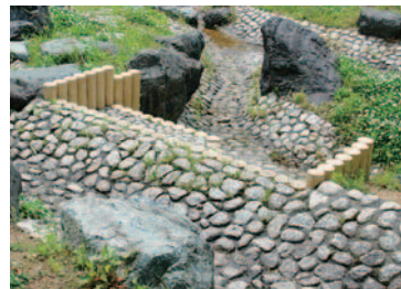
洗堰の模型(洗堰公園内)
