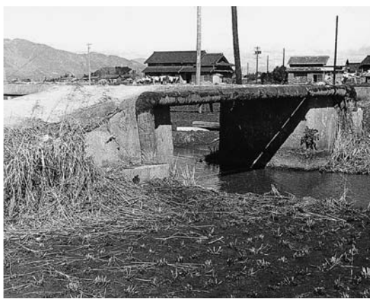
耕地整理前の水路にかかる橋（橋の下は舟を通行させるため台形上になっている）
