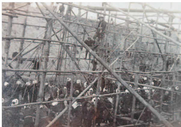
大正2年 小島地区の樋門の建設風景②
