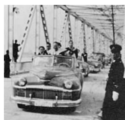
濃尾大橋開通・渡り初め
