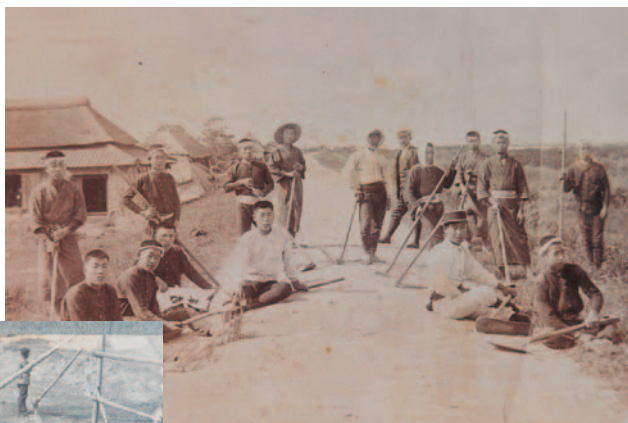
大正2年 小島地区の樋門の建設風景①
