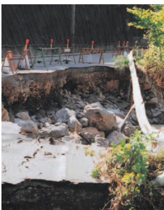
台風で陥没した道路 (平成14年7月台風6号時)
