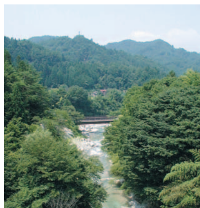
蛇抜けが発生した与川
