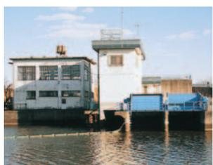
大巻ポンプ場(右)上の鉄筋2階建とその左下に明治27年、東海で初めて建設した排水機のレンガの基礎が残っている(岐阜県養老町大巻)
