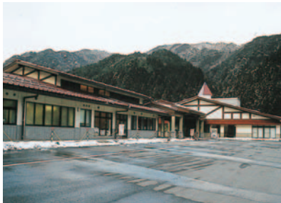
板取老人福祉センター全景
