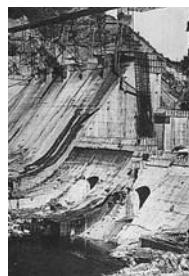
完成間近(大正13年)の木曾川・大井ダム タムの完成によって材木の流送は不可能になつた
