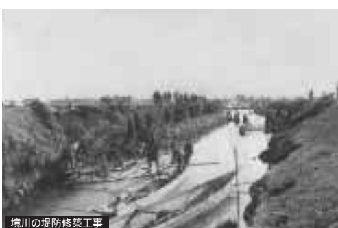
境川の堤防修築工事
