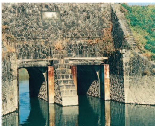
写真3) 近六開門 明治40年5月、たたき工法で築造した逆水留樋門下流側 1988年11月撮影
