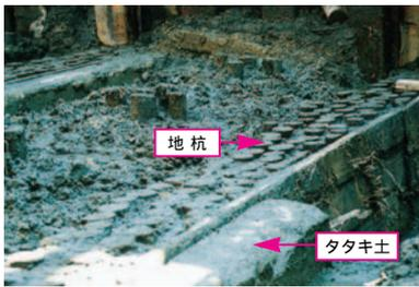
地杭、土金板とタタキ土の施工状況
