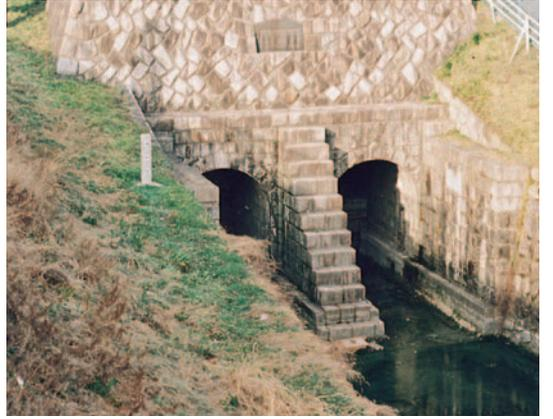
写真4) 庄内用水元枳樋(明治43年たき工法で築造)1991年3月撮影
