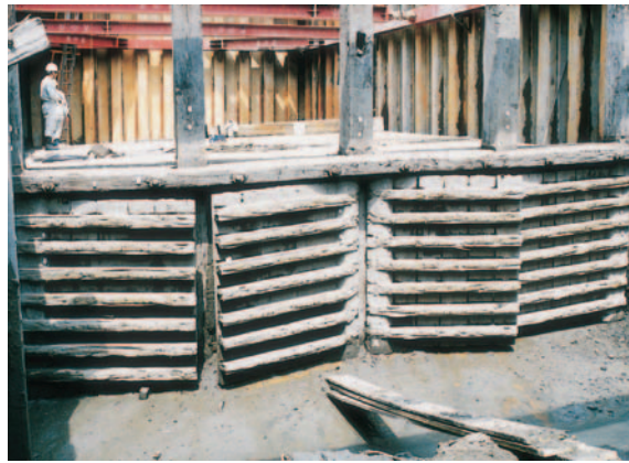
揖斐川側に取付けられている観音開戸
