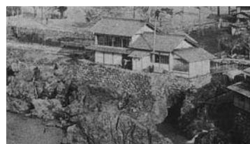
八幡水力電気会社の発電所
