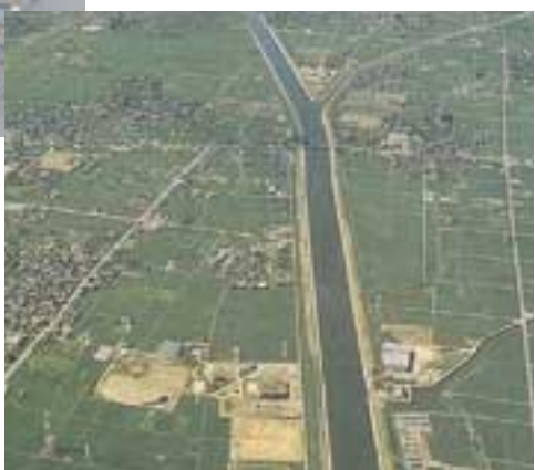
日光川下流部改修状況
