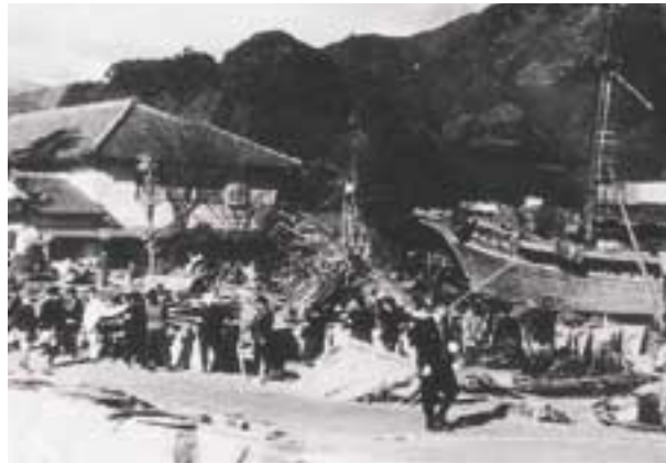
東南海地震 三重県尾鷲港における津波被害船乗り上げ家屋破壊
