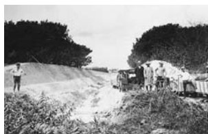
佐屋川用水工事の風景
