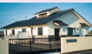
鵜多須地区排水処理施設
