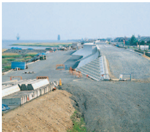
高潮堤防補強工事〈揖斐川右岸2.6km付近〉ルート23号より下流を望む
