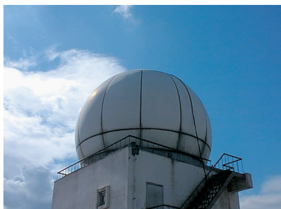
名古屋地方気象台の気象レーダードーム
