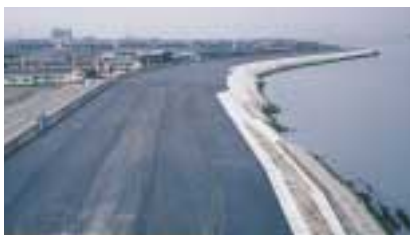
揖斐川左岸高潮堤（前小段造成）
