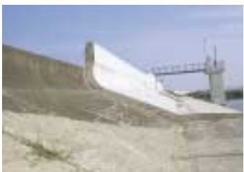
パラペット緊急高上げ工事
