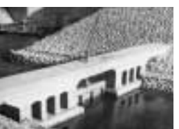
佐屋川用水取水口
