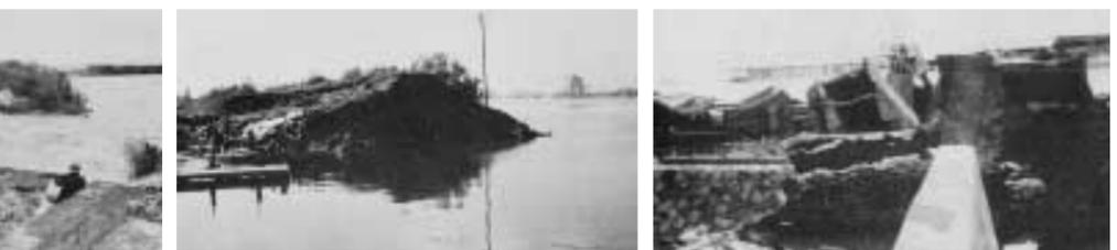
mを越す高潮は考えられませんが、たが、記録を破る高潮に襲われ、しかも堤防法線が高潮波の進行方向に直角なため、まともにも高潮被害を受けました。痕跡をみると堤防上二〇〜二〇m位は越えているようで、この越水、越波によって、被覆していない天端と裏法が崩壊、ついに胸壁の下がえぐられ、さらには護岸が崩壊し、破堤に至ったと考えられます。
