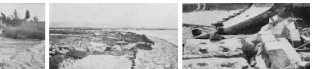
木曾岬沿岸は、被災前には堤防前面に家屋が密集、低い堤防、小さな断面の悪条件に加え、護岸も整備されていなかったため、波浪と高潮によって、堤防は一瞬にして全延長にわたって破堤したものとされています。
