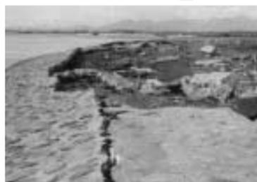
根こそぎ破壊された海岸堤 (伊勢湾台風30年記念誌写真提供)
