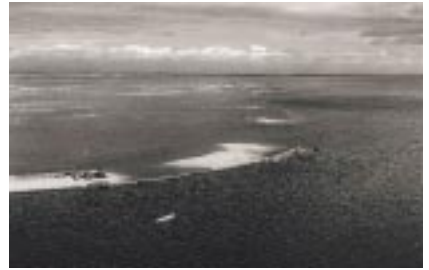
鍋田干拓堤防災害風景
