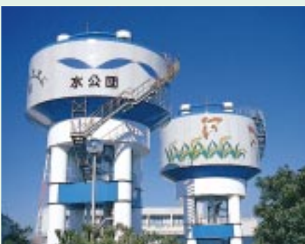
弥富揚水機サージタンク（調圧水槽）
