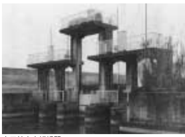
立田輪中立切樋門
