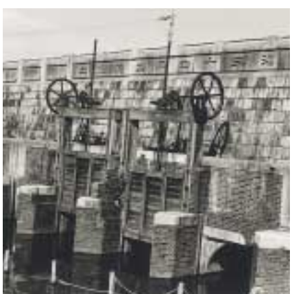
立田恵水中山樋門
