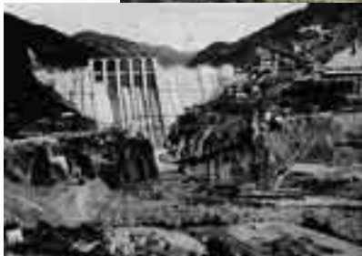
建設中の丸山ダム(昭和28年)
