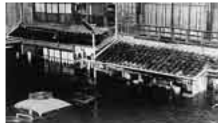
昭和58年台風10号による洪水
