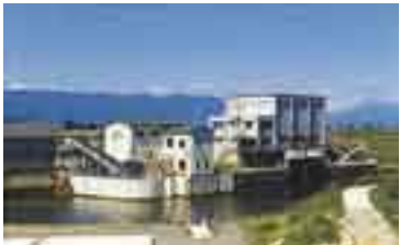
桑原町小藪にある排水機群
