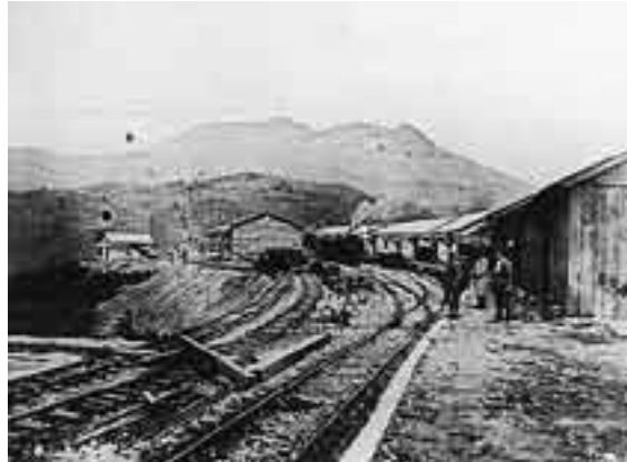
資源運搬軌道終点付近
