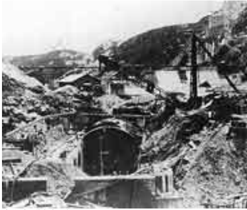
大井ダム導水路工事
