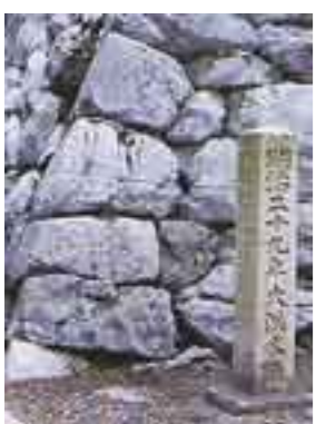
天守閣石垣下部洪水点標柱
