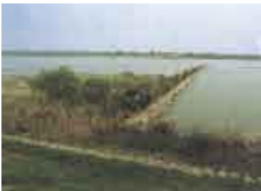
木曾川右岸の水制工
