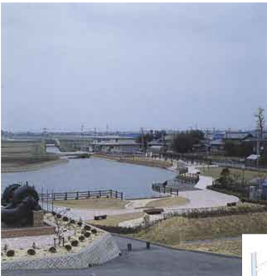
脇野揚水機場と白山公園
