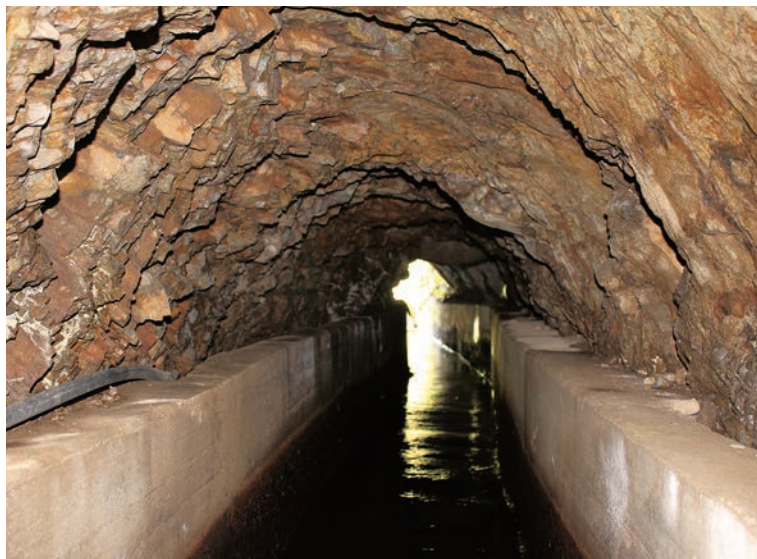
福野隧道の内部。現在はコンクリートで補修されている。
