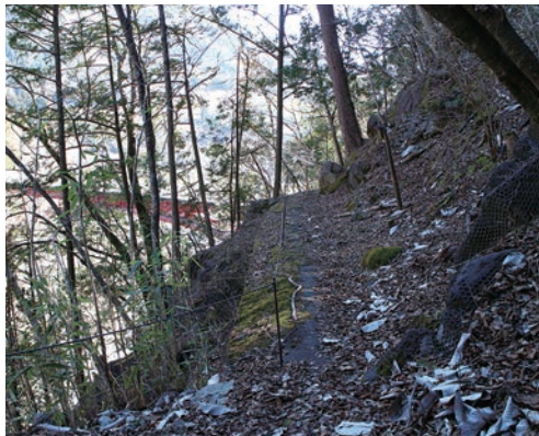
岩壁に造られた西股用水路（蓋がしてある）奥に見える橋は元谷橋。
