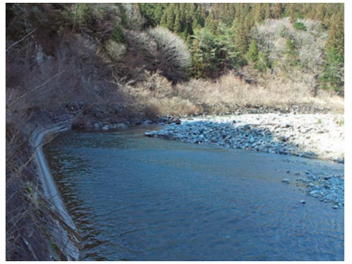
旧取水口「鱒淵」 現取水口は800m下流にある権四蔭堰堤であり、「鱒淵」は堰堤による土砂堆積で埋没している。
