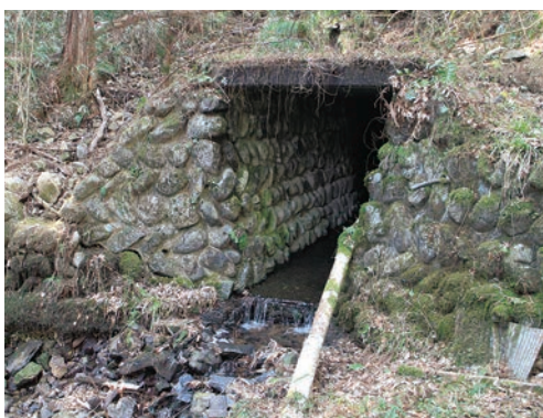
「若宮隧道」 隧道脇に開通時に祀った水神様が祀られ、隧道から出ている白いパイプで恵北浄化センターへ上水を送っている。
