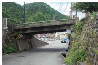
東側河川に架けられた橋梁
