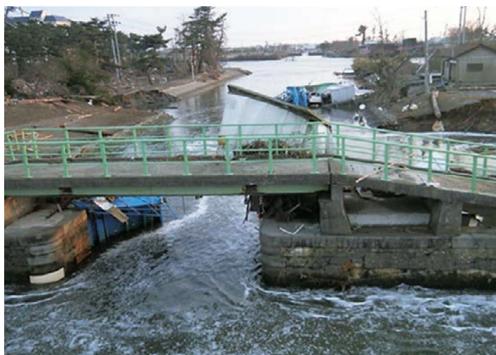
被災前の釜閘門（平成22年10月撮影） <出典：『北上運河「釜閘門（定川北閘門）」遺構調査』 平成29年3月 宮城県東部土木事務所>
