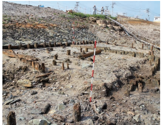
現れた法尻の丸太、矢板、「ほぞ組み」の角材等
