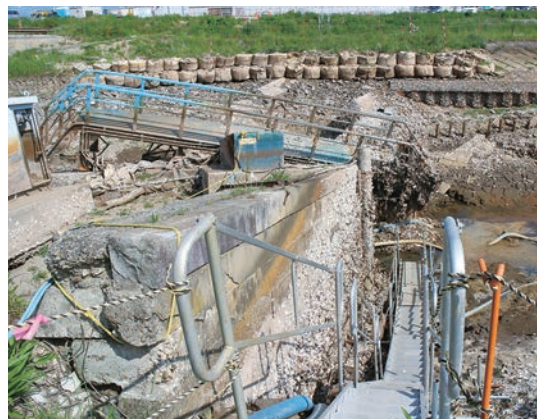
コンクリート施工後、モルタルで石形の目地を入れていた
