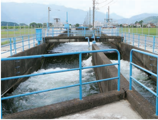
揖斐川町上ミ野（かみの）の揖東・西郡分水工（右岸側 揖東用水、左岸側 西郡用水）
