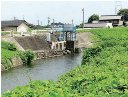
衣斐用水への島樋門。取水後、右岸揖東・中央中島・左岸衣斐用水に分水される。
