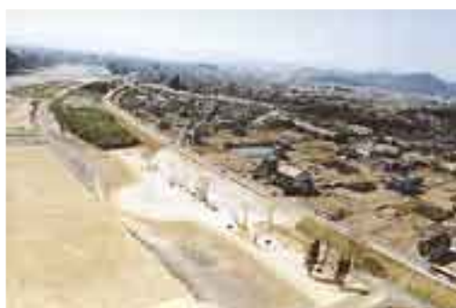
雄総地区高水敷の整備
