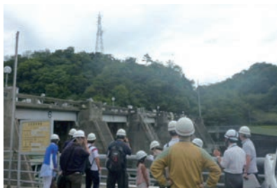
西平ダム（中部電力株式会社）
