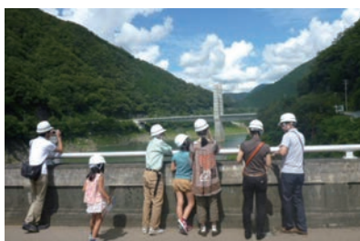
横山ダム（横山ダム管理支所）
