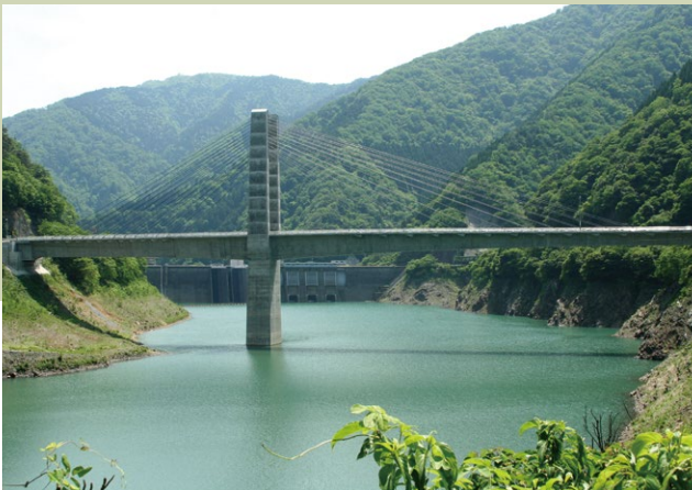
完成した奥いび湖大橋
