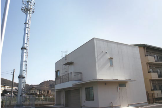
ダム操作遠隔化のための分室整備完了
