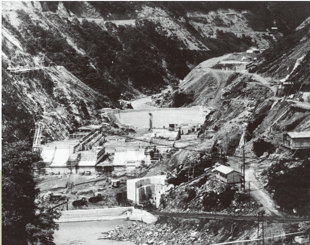
打設初期(下流より)
