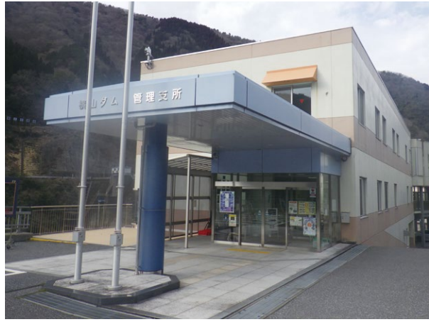
木曽川水系ダム統合管理事務所、横山ダム管理支所に改組
