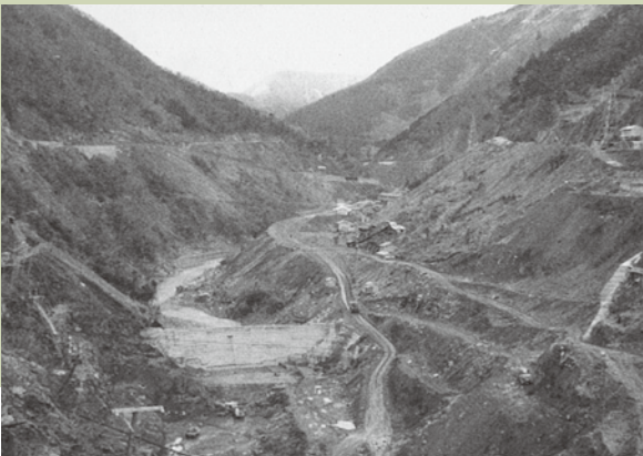
ダムサイト(下流より)
