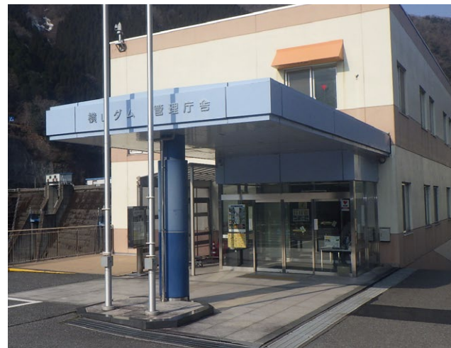
横山ダム管理庁舎玄関
