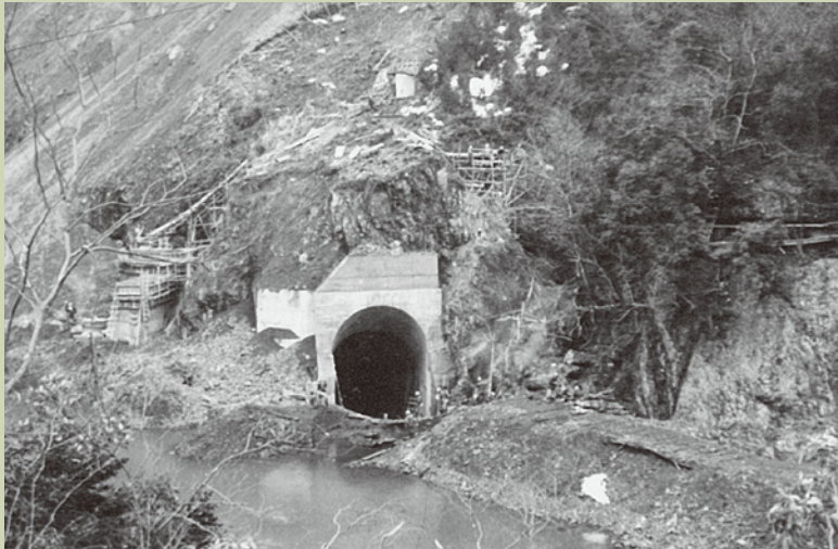
右岸転流工 坑口
