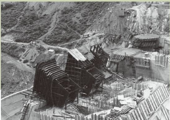
本体及びオリフィス管設置状況
