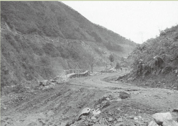
ダムサイト左岸
