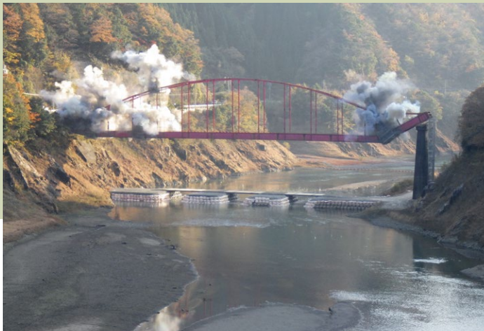
新川尻橋撤去
