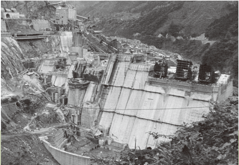
本体及びオリフィス管設置
