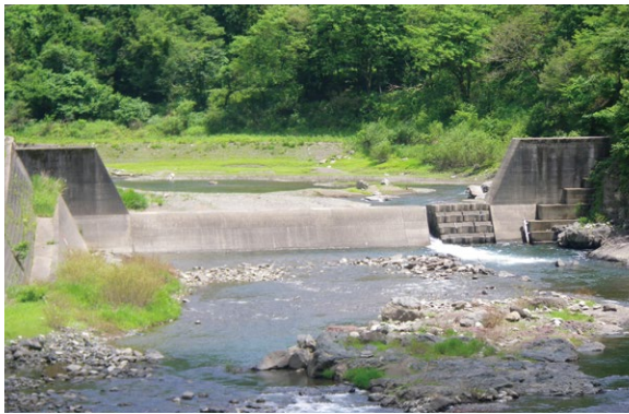
完成した揖斐川貯砂ダム
