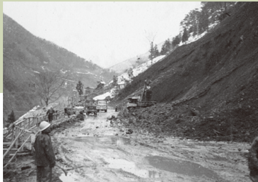
左岸仮設道路
