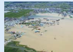
平成14年7月洪水 大谷川の浸水状況
