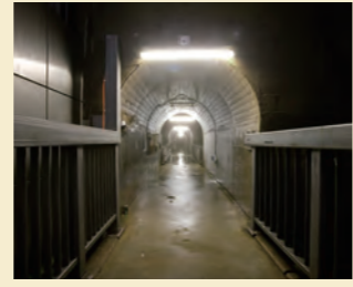
②監査廊 堤体内を観察するためにダム堤体内につくられた通路。通廊とも呼ばれます。
