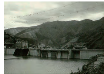
完成間近／試験湛水中（上流より）
