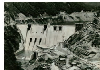
完成間近／試験湛水中（下流より）
