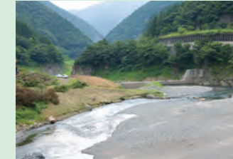
坂内川貯砂堰
