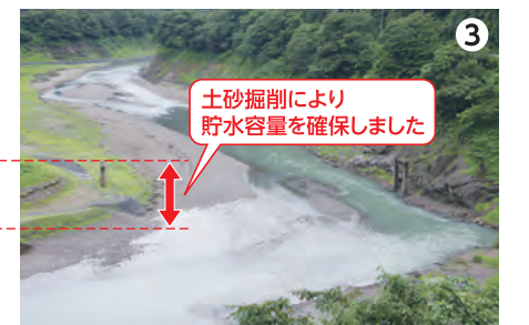
掘削工事後（平成23年）
