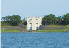
Drenagem de abastecimento de água da Cidade de Nagoya
