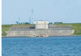
Drenagem de abastecimento de água da Prefeitura de Aichi
