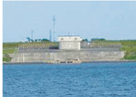
愛知県水道取水口
