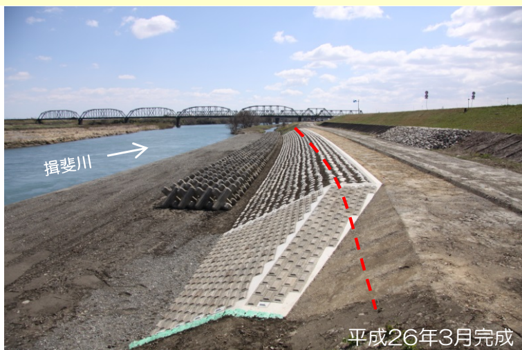
揖斐川津村低水護岸工事（施工者：高田建設（株））
