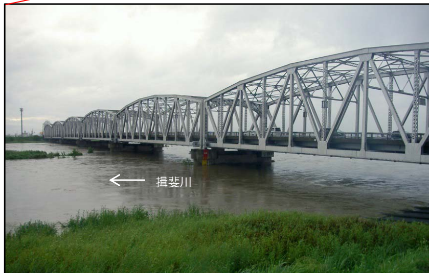
揖斐大橋（万石地点）の増水状況 8月10日 18時50分
