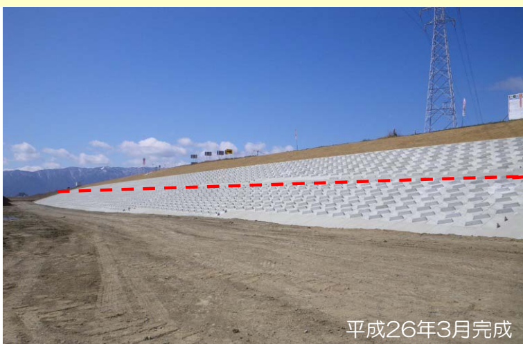
揖斐川今福築堤護岸工事（施工者：（株）所組）
