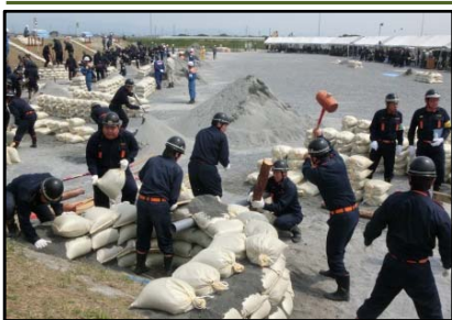
水防工法（月の輪工）
