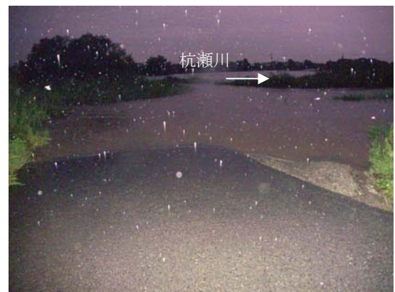
新幹線杭瀬川橋・右岸下流地点の出水状況 (9/4 23 時)
