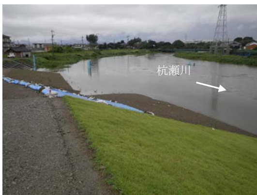
杭瀬川 8.4K 付近の出水状況 (9/4 17 時)
