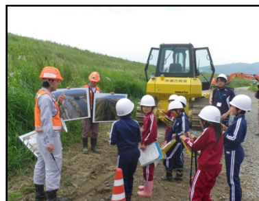
重機を前にした工事説明
